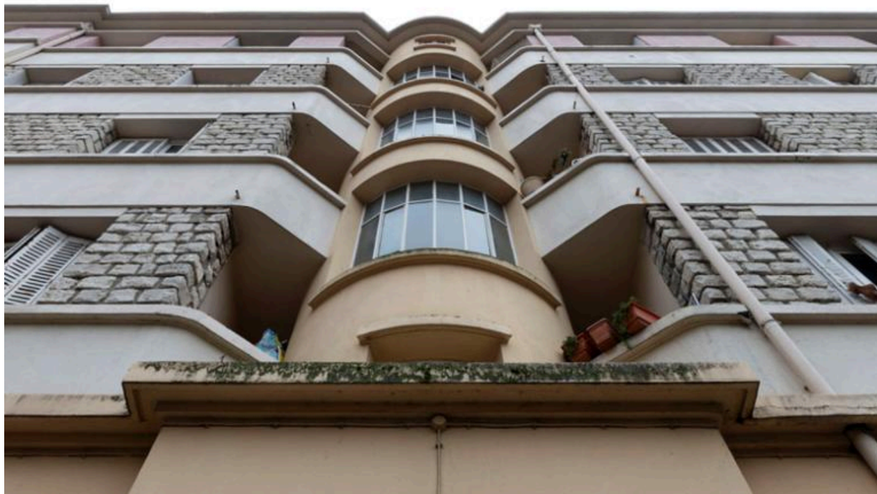
Vue en contre-plongée d'une cage d'escalier depuis la cour.
