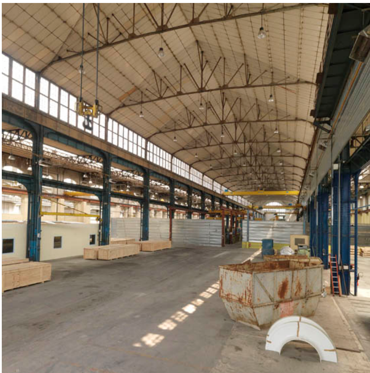
Vue intérieure de la nef centrale. Montage, machines-outils (1901-1903). Actuellement entreprise Jeumont Electric. Charpente et poteaux métalliques.
