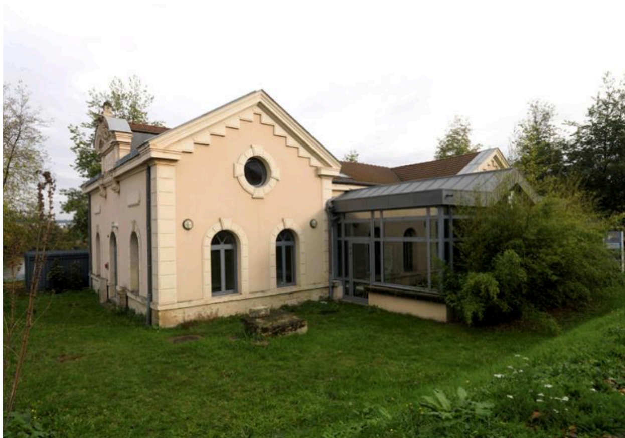
Vue de l'aile gauche du bâtiment, ouvrant sur la promenade des Cordeliers.
