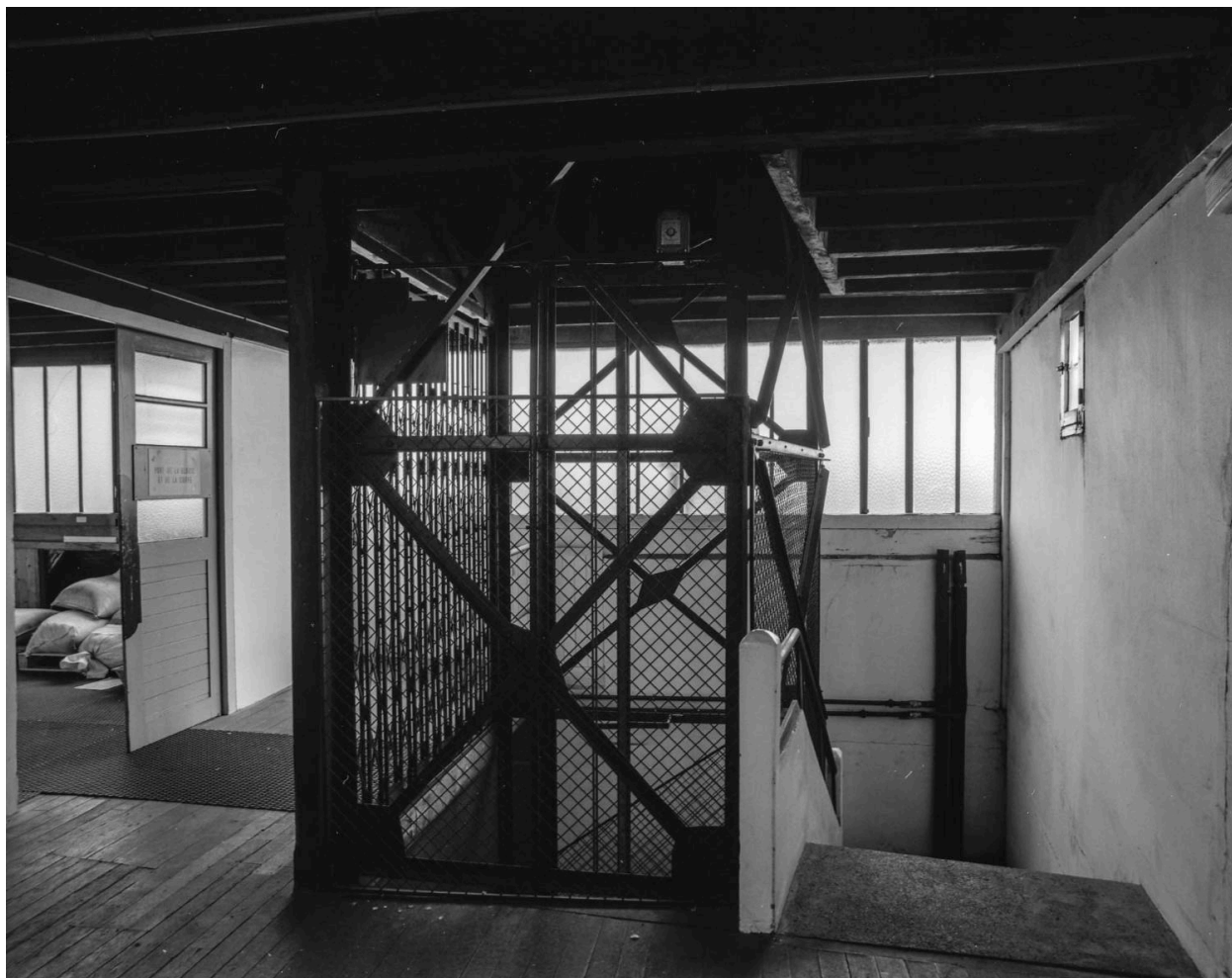
Bâtiment principal, cage du monte charge.
