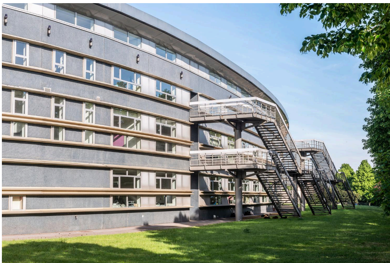
Détail de la façade nord, du côté de la voie rapide.
