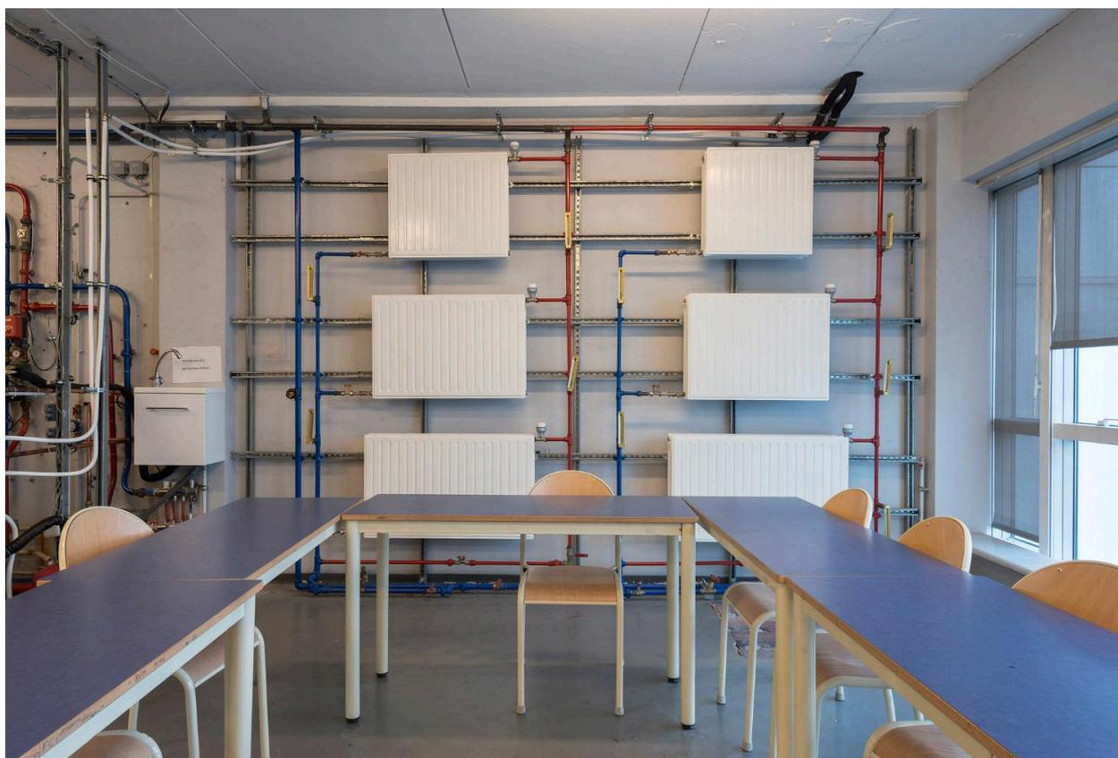
Les salles d'apprentissage pour l'installation et la maintenance des systèmes énergétiques, avec ici des radiateurs pour pratiquer.
