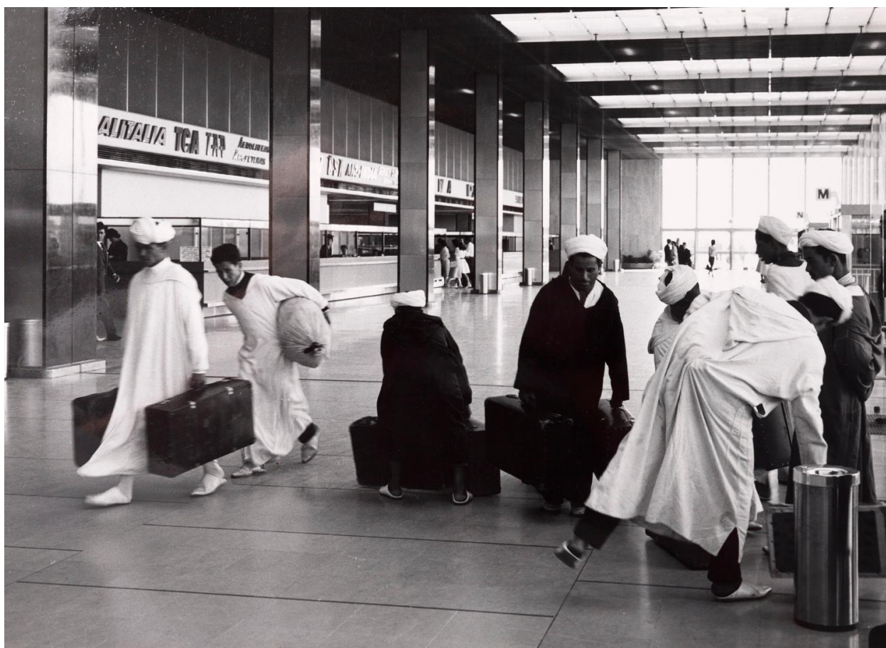
Le Grand Hall, rez-de-chaussée, "Orly Installations Terminales", album de photographies destinées à la presse édité par l'Aéroport de Paris, 1961.
