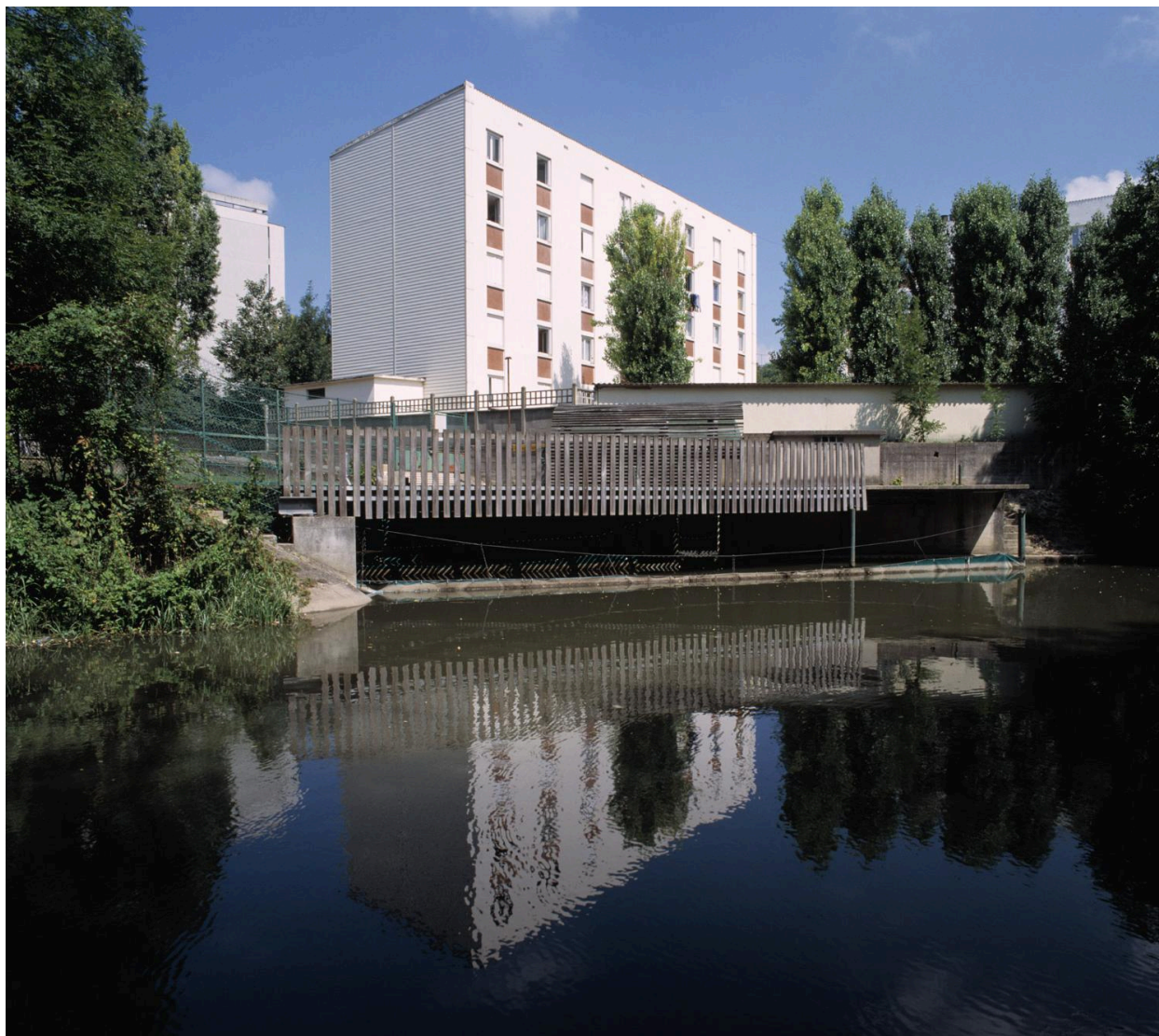
La station d'épuration des eaux pluviales des pistes d'Orly et les immeubles du Clos Perault.
