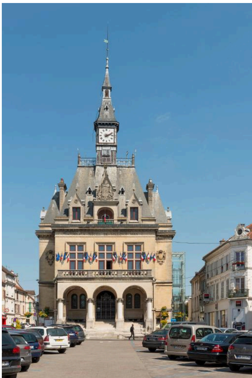
La façade occidentale : vue frontale.
