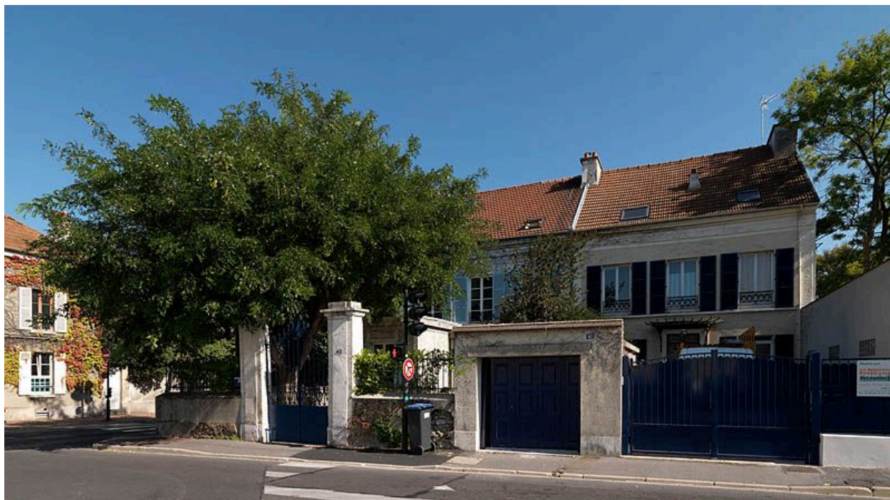
Maisons de type "fausses jumelles" aux 40 et 42, rue Saint-Faron.
