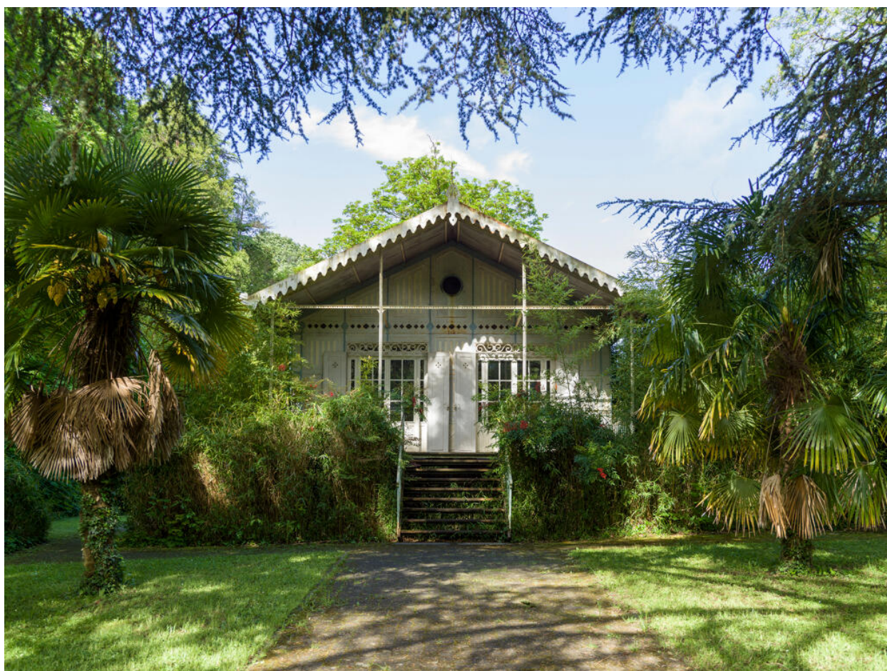
La façade sur jardin, orientée vers l'ouest.
