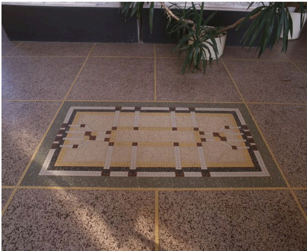
Détail d'un panneau décoratif en mosaïque sur le sol en granito du hall d'entrée.
