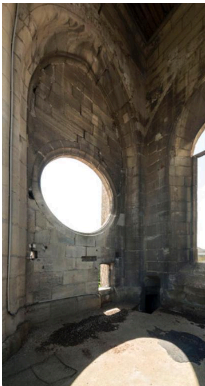
Oculus éclairant le premier étage.
