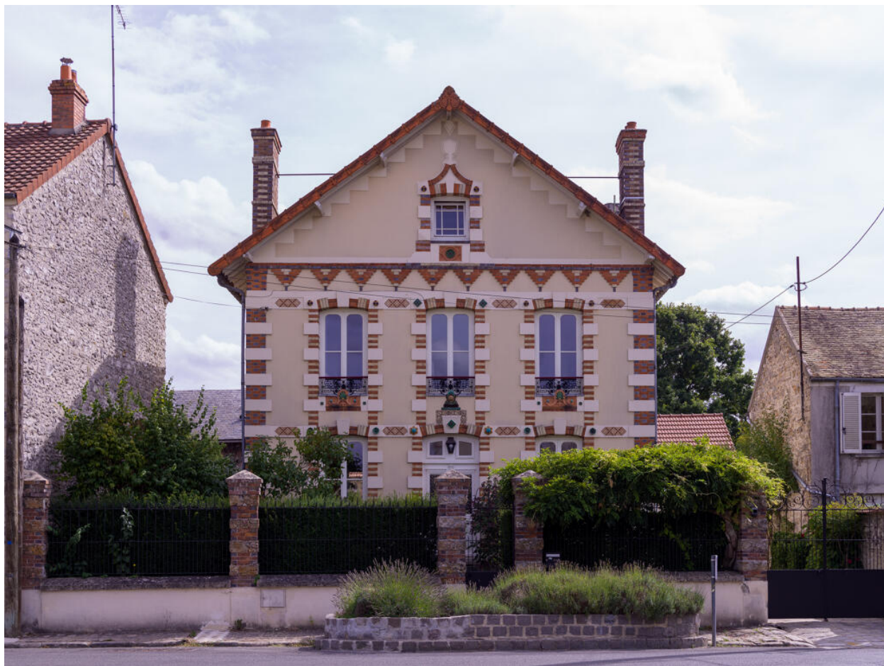
Vue générale de la façade nord, donnant sur la rue.
