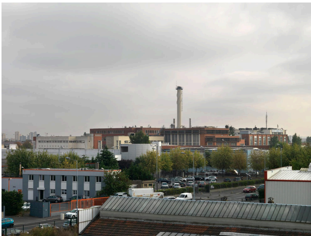
Site Sanofi. Vue générale du site.
