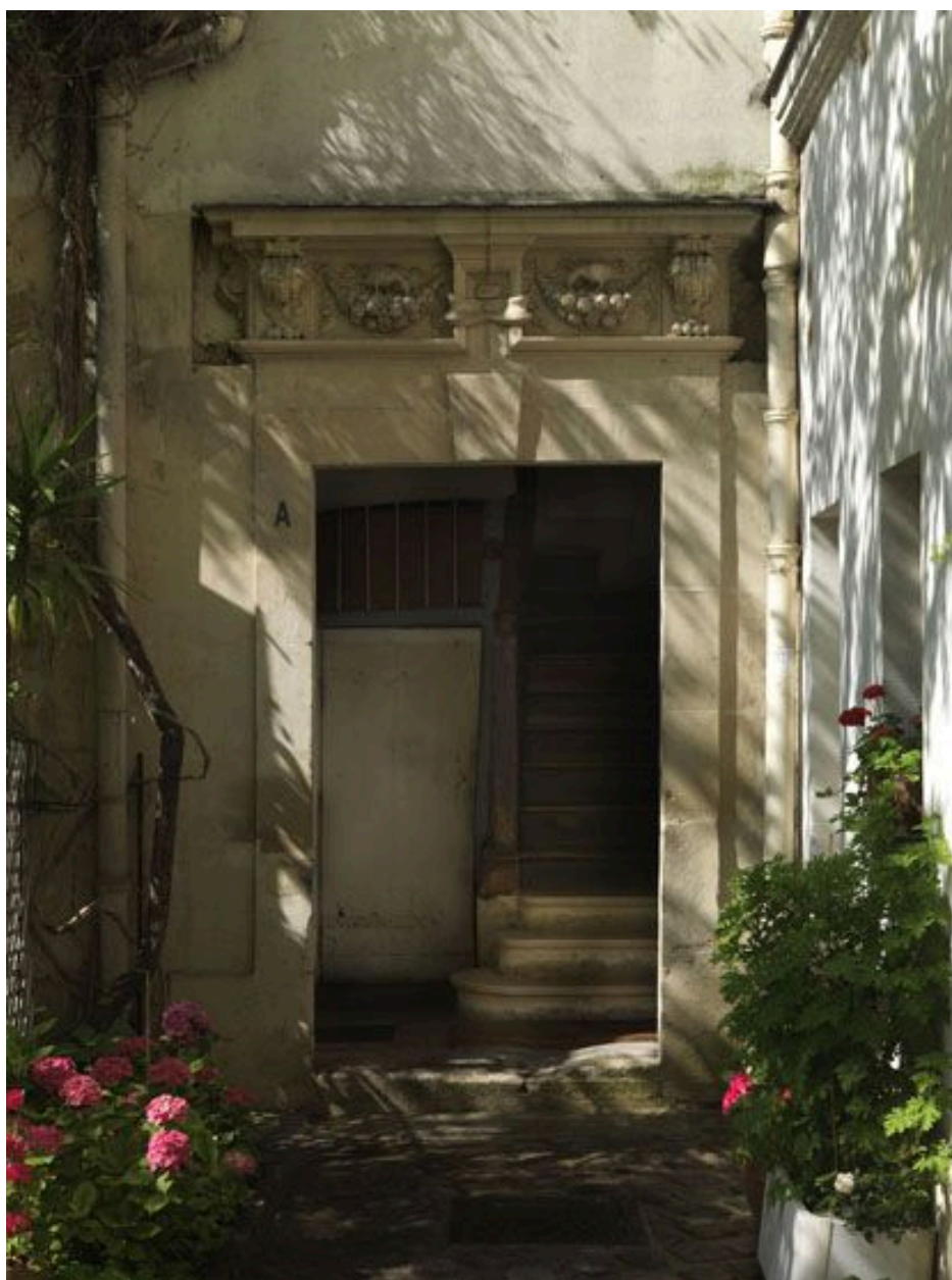
Vue de la porte desservant l'escalier à balustres de bois à droite de la cour (escalier a).
