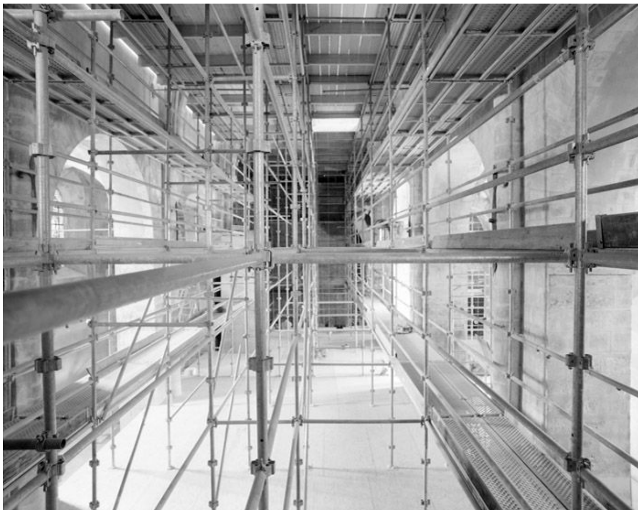
Restauration de la nef (2005) : l'échaffaudage intérieur.
