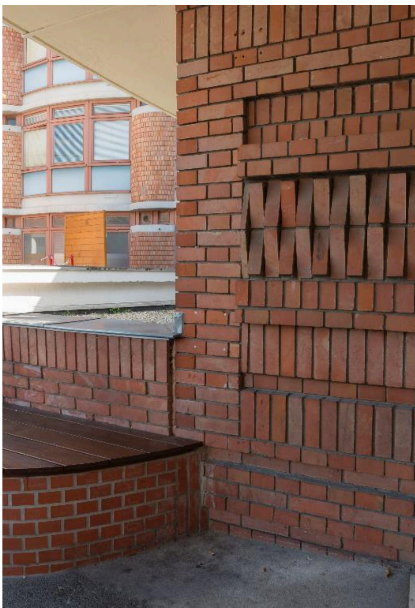
Vue de l'appareillage de briques au niveau de l'entrée de la façade principale.
