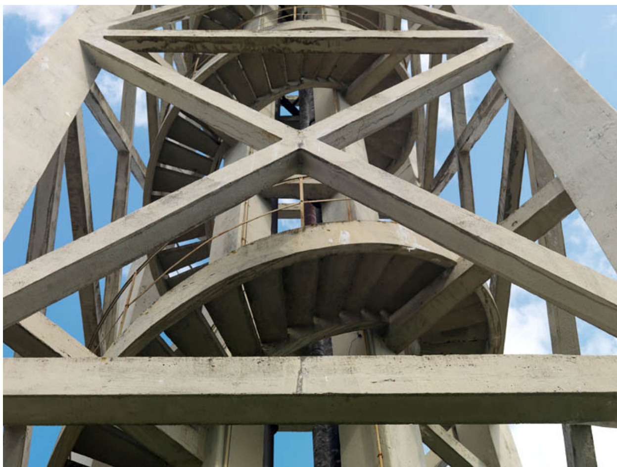
Détail de l'escalier du château d'eau (1902). Ciment armé.
