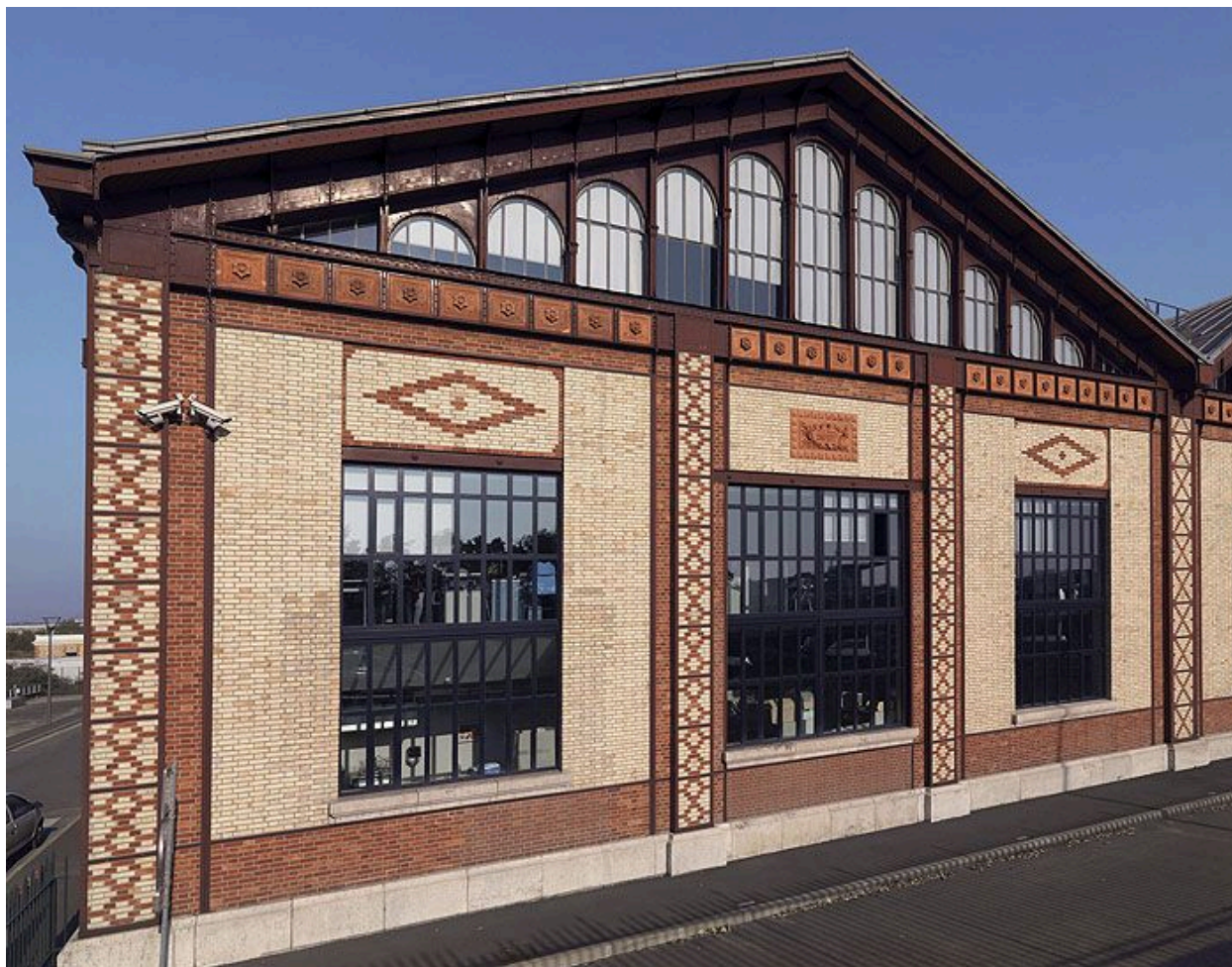
92, Colombes, établissement éleveur des eaux, Paul-Bert (rue) 82. Façade pignon sur le boulevard Louis Seguin.
