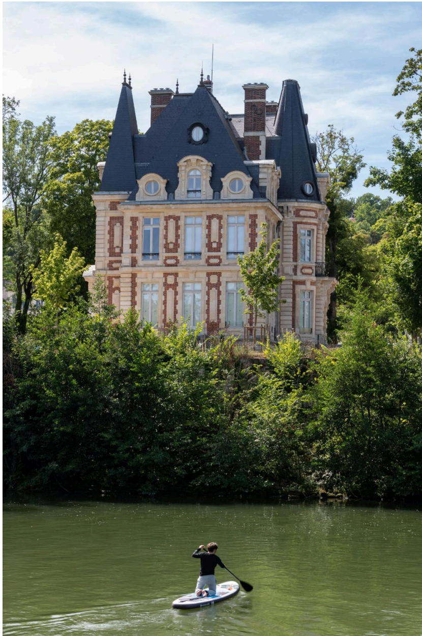
Vue générale du château Conti depuis la rive droite de l'Oise et la gare de Parmain.
