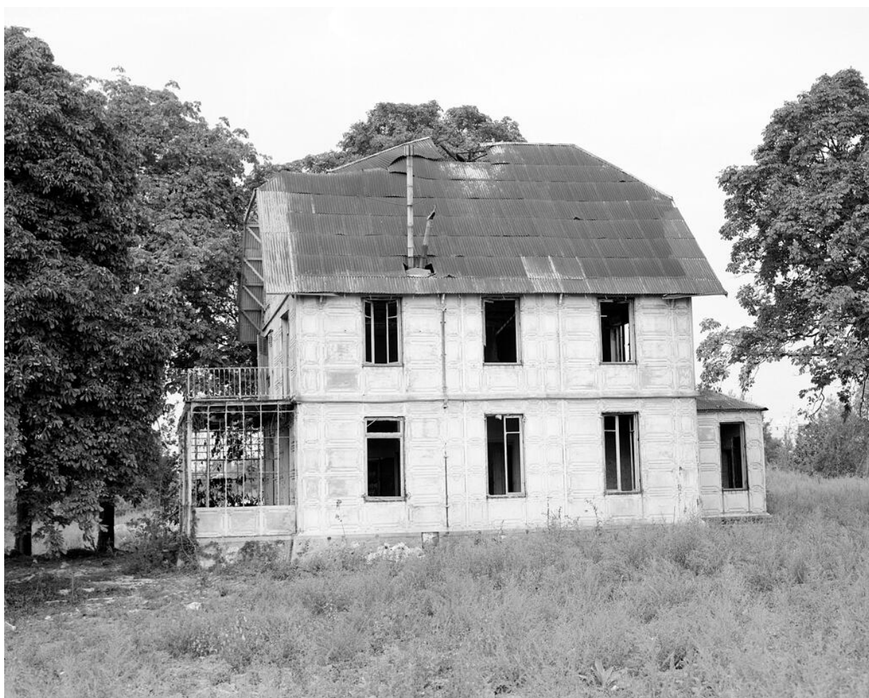
Vue d'ensemble d'une façade latérale (état en 1991).
