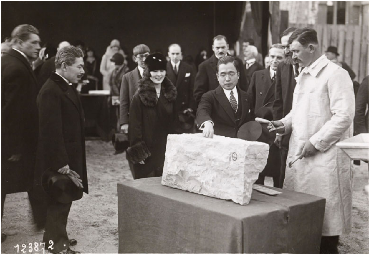
Pose de la première pierre par le prince héritier du Japon, le 12 octobre 1927 ; à l'arrière plan, le peintre Foujita. Devred G., Agence Rol (photographe), 4 rue Richer, Paris 9e. Photographie. CIUP, centre de valorisation du patrimoine, P/TP-B31-1065.
