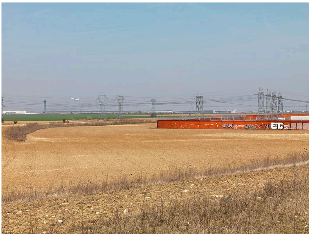
93, Tremblay-en-France. Poste électrique, champs et aéroport.
