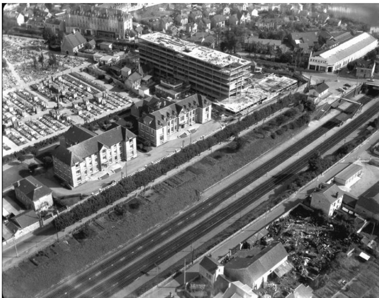
Les bâtiments construits par Raymond Marabout dans les années 30. A droite le pavillon de chirurgie, à gauche la maternité. (Fonds Bertin).
