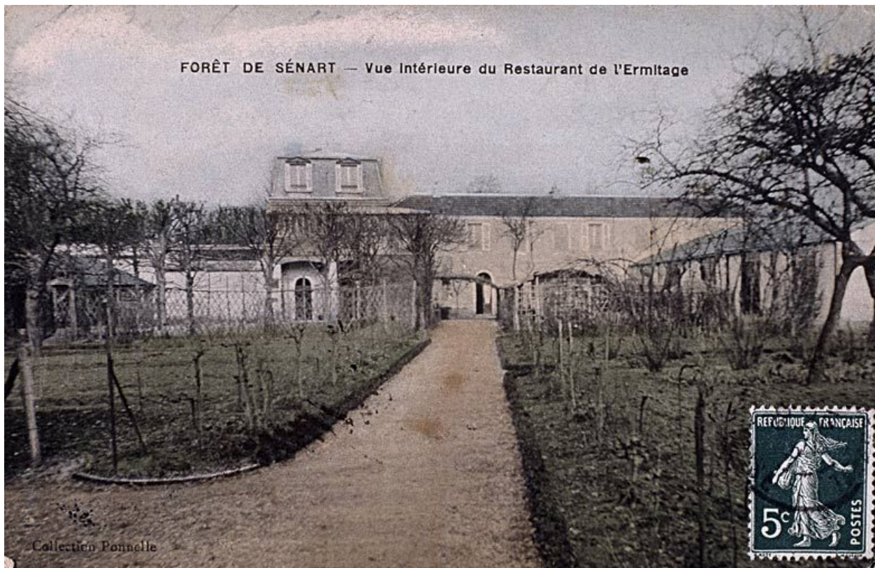
Les bâtiments de l'ancien ermitage transformés en hôtel-restarant. Carte postale, vers 1910. (AD Essonne, 2 Fi 63)
