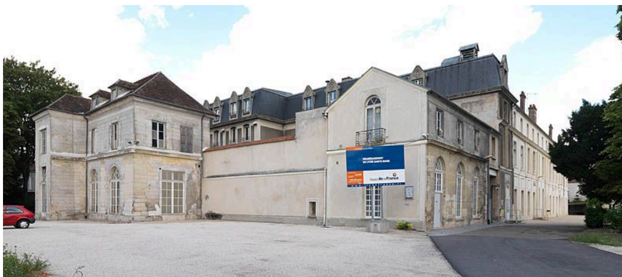
Vue de l'angle sud-est des bâtiments de l'ancienne abbaye de Chaage : ancienne sacristie, ex-chapelle du Rosaire puis Orangerie Dassy.
