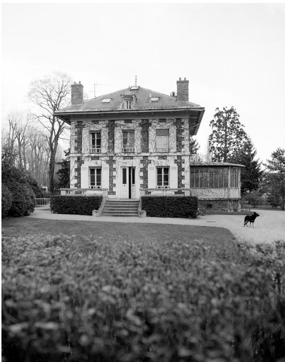
Vue d'ensemble, façade antérieure.
