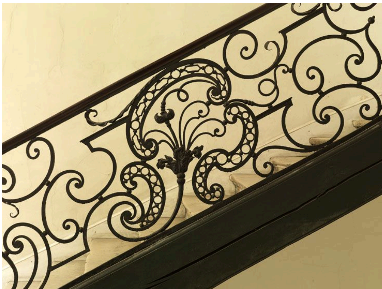
Escalier principal : le premier panneau rampant détail du motif central.
