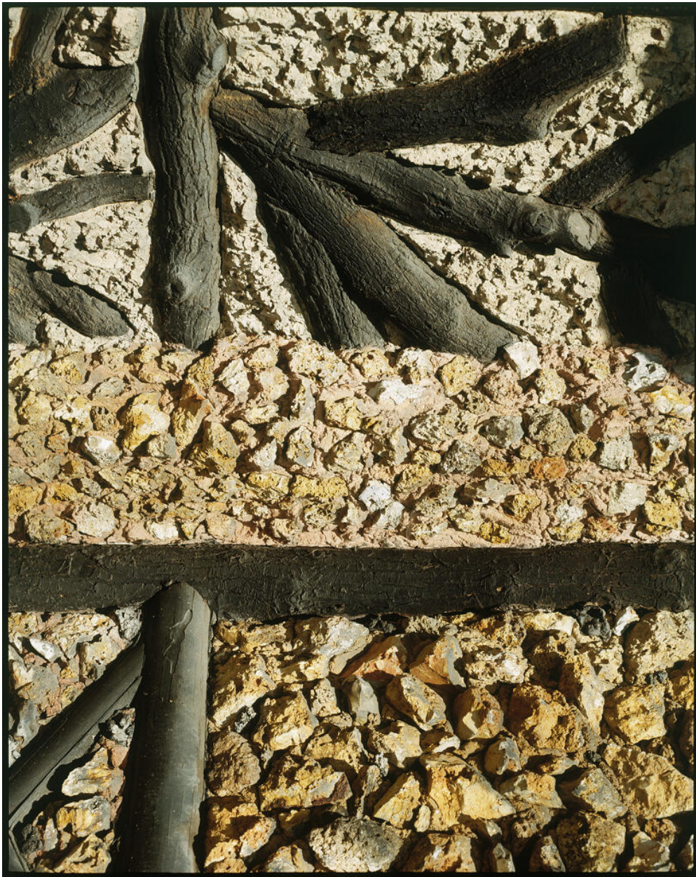
Détail des matériaux sur la façade postérieure : bois et meulière.
