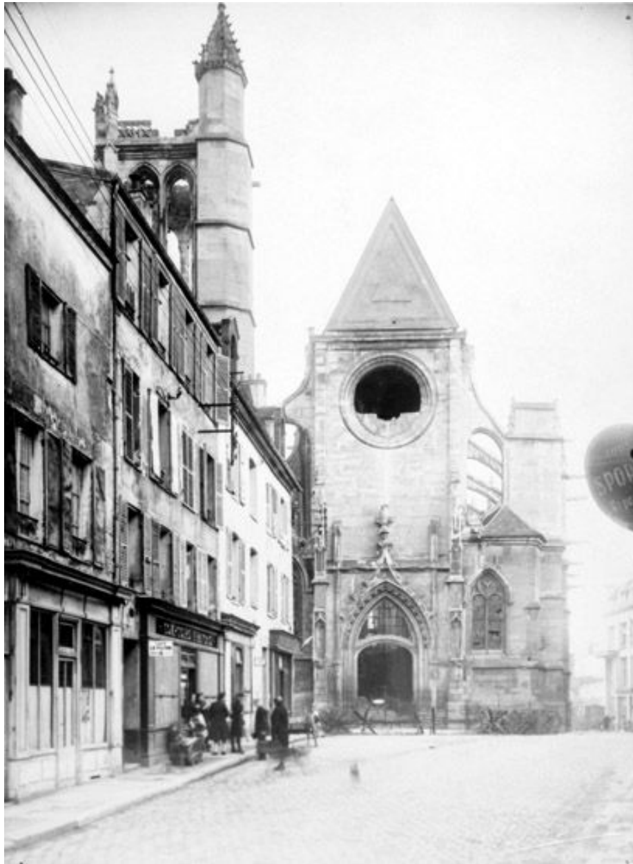
L'église après son bombardement lors de la Seconde guerre mondiale, vue depuis l'ouest. Photographie, vers 1944. (AM Melun. 3 Fi 21)
