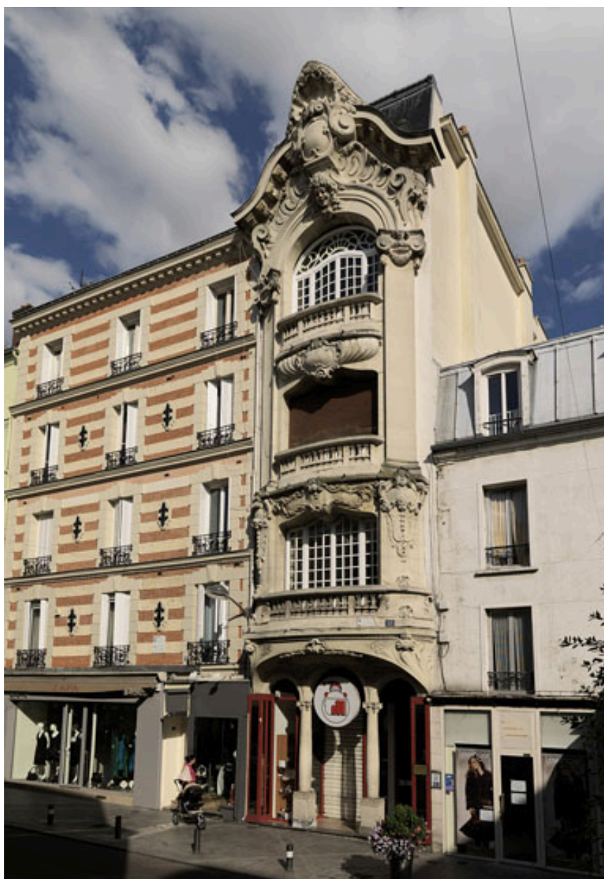
Vue d'ensemble depuis la rue.
