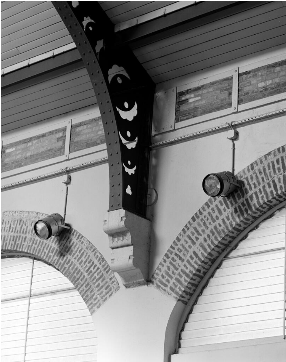
Gymnase. Détail du mur nord, entre deux travées. Lycée dit Lycée Lakanal
