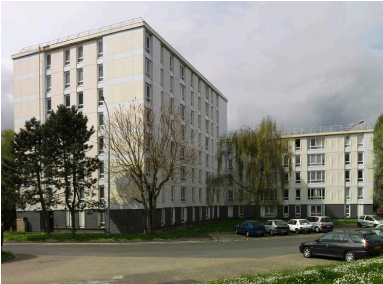
Vue générale des immeubles du secteur dit "ouest" du Pont-du-Routoir, à proximité de la rue Pierre Brossolette.
