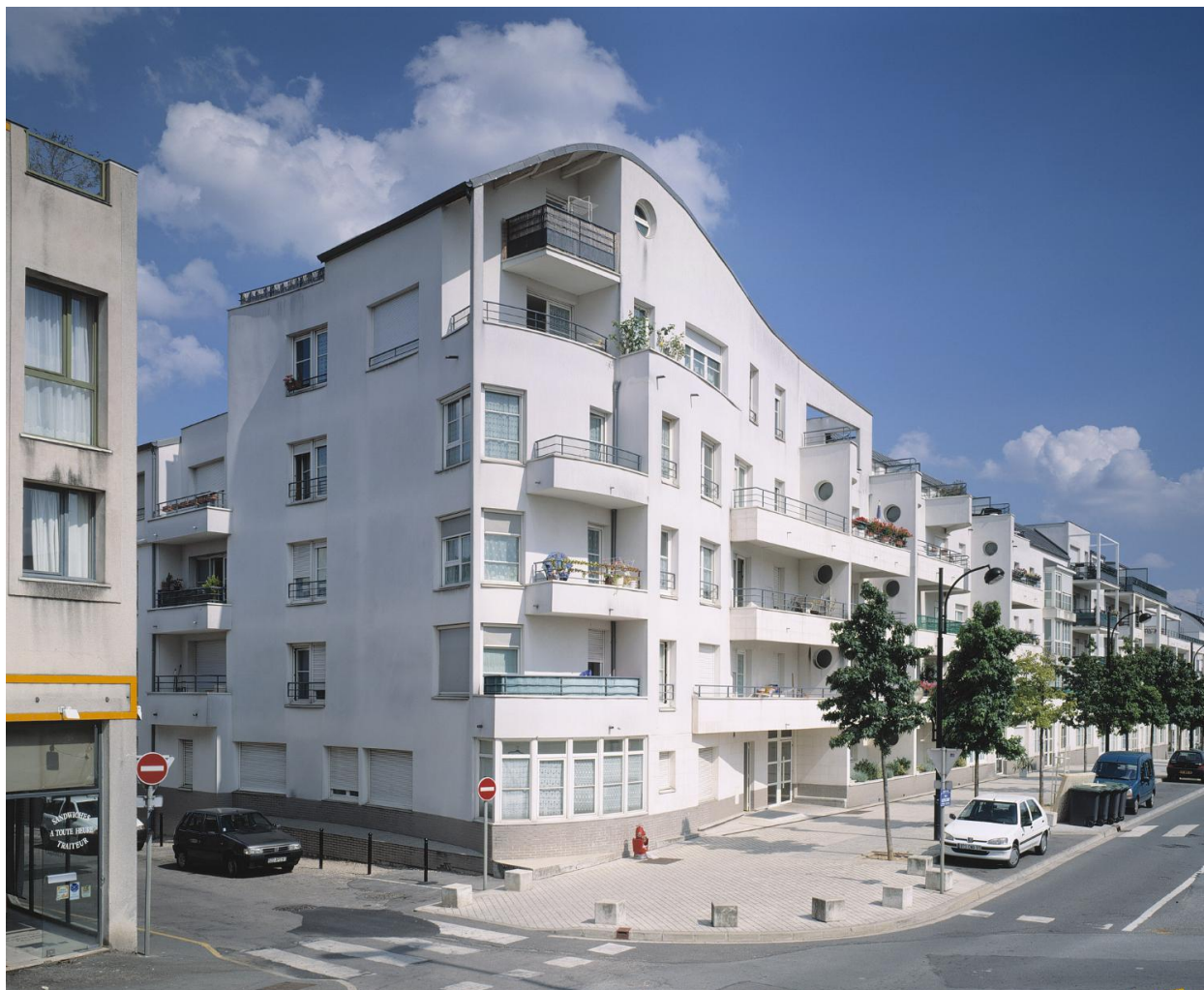
L'un des immeubles du centre-ville rénové.
