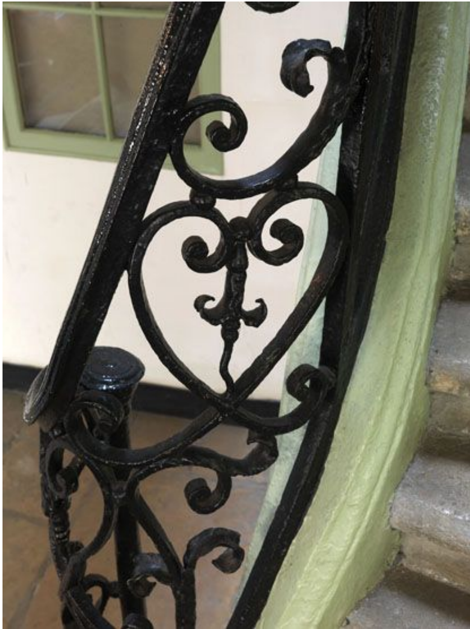
Détail du départ de l'escalier.
