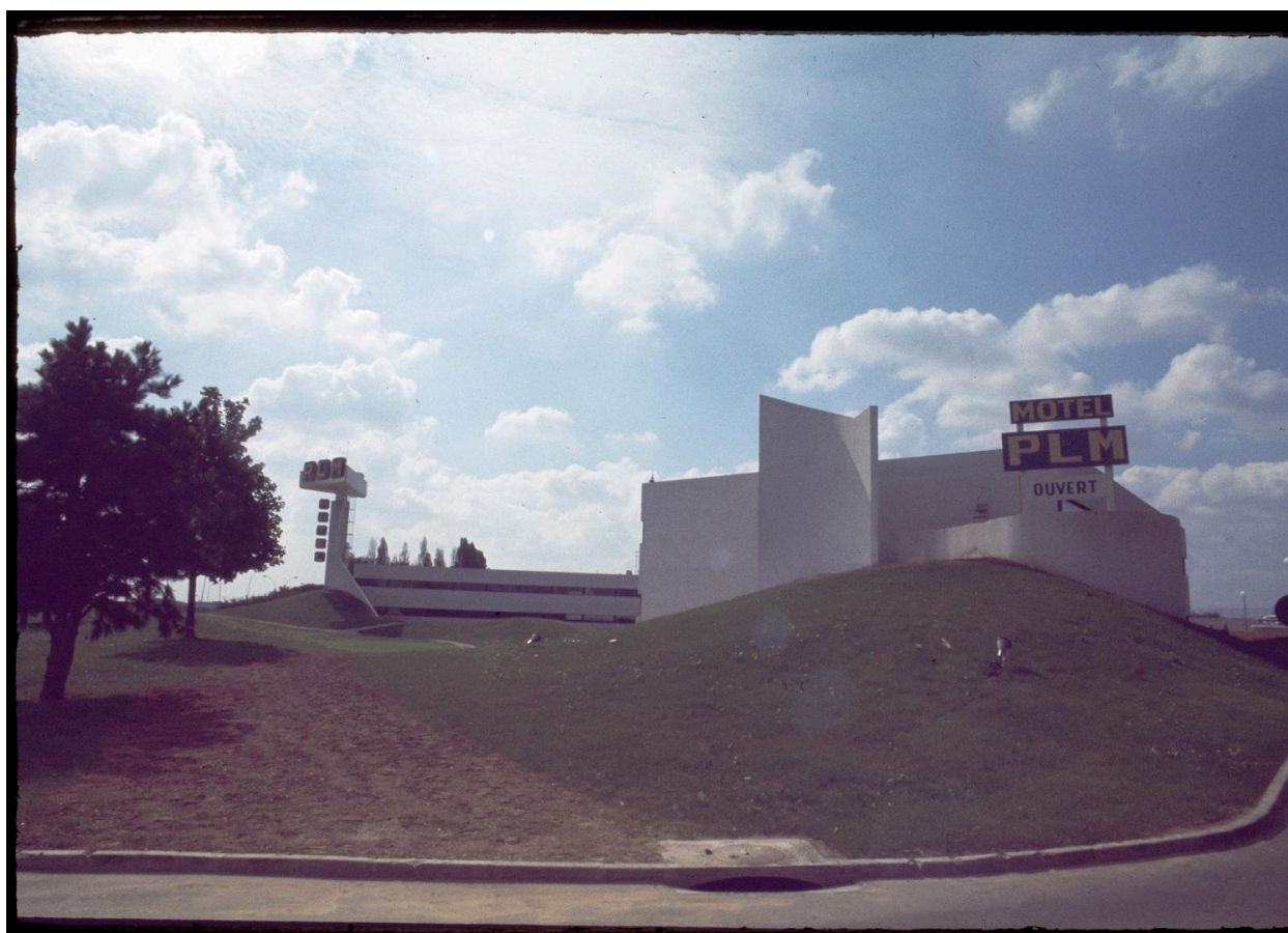
09/1973, l'hôtel PLM au nord d'Orly-Sud vu depuis le sud.
