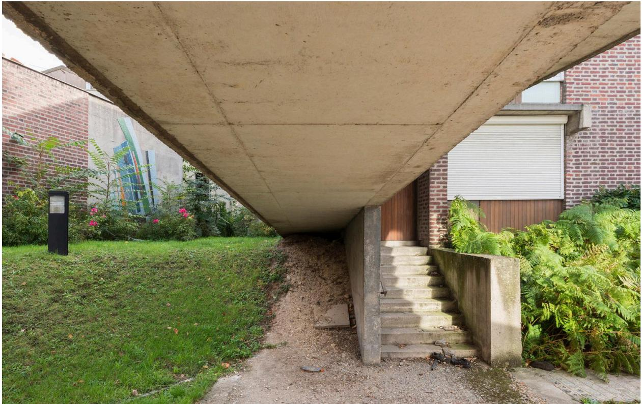
Détail de la rampe sud-est, vue du dessous, avec son béton brut.
