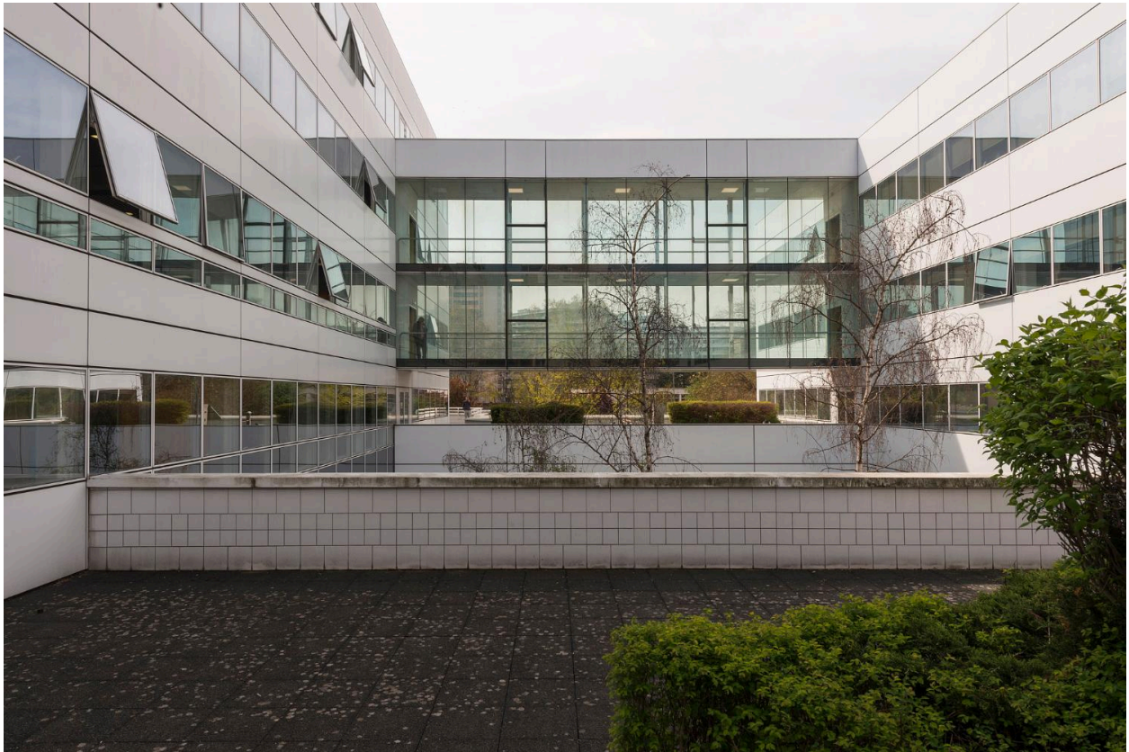
Détail des liaisons vitrées entre les bâtiments.
