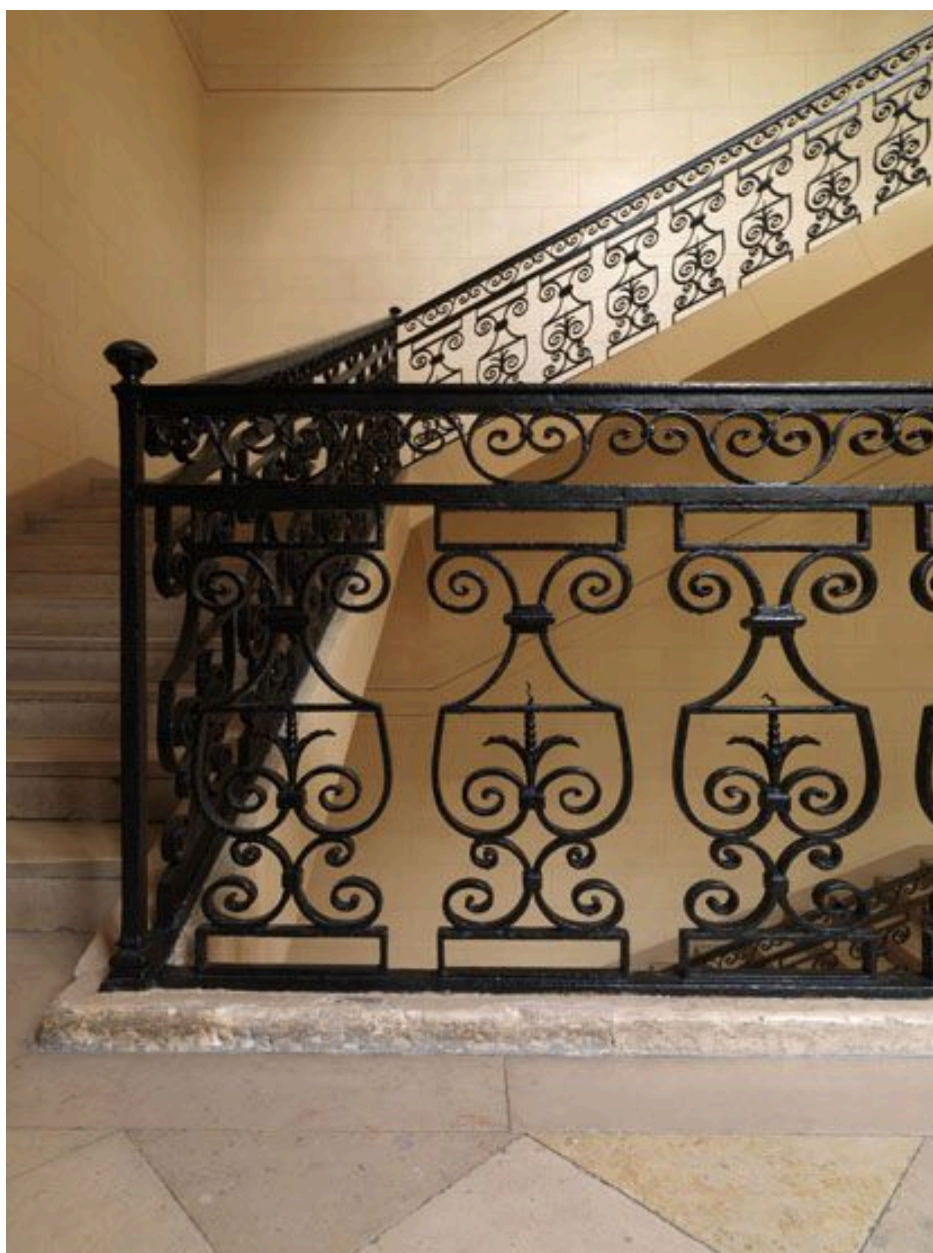
Détail des balustres.
