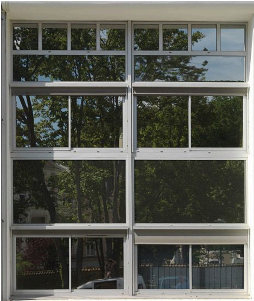
Détail des ouvertures de la façade orientale de l'ancienne station d'essai PIC, après réhabilitation.
