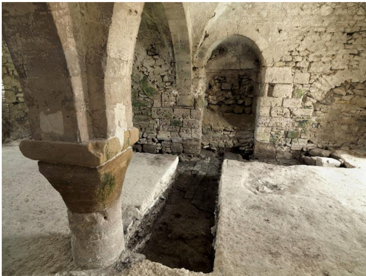
Vue sur la salle 4 de la grange des Beauvais.
