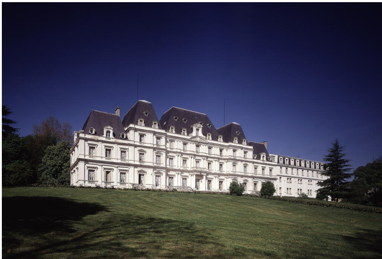
La façade sur le parc. A droite, la chapelle des Assomptionnistes convertie en chambres.
