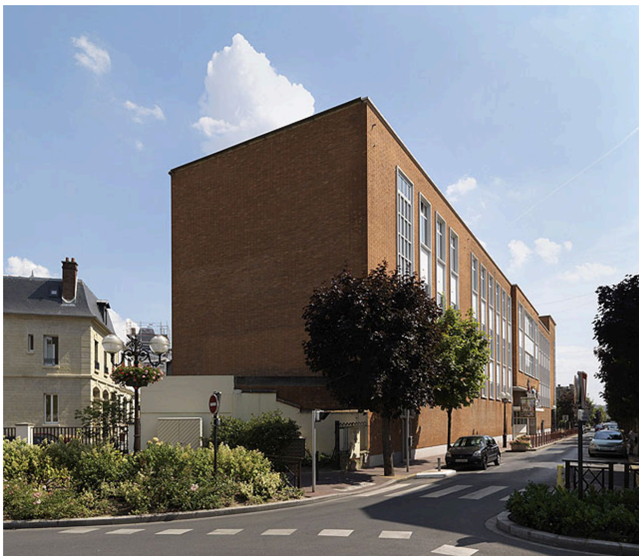
Vue en perspective du bâtiment des années 1930, sur le boulevard d'Ormesson.
