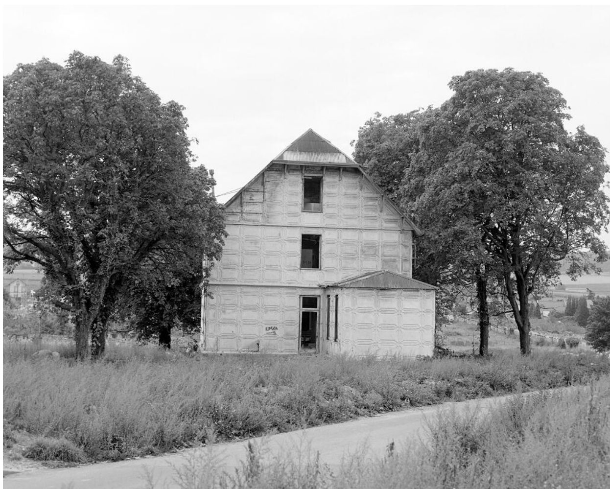
Vue d'ensemble de la façade d'entrée (état en 1991).
