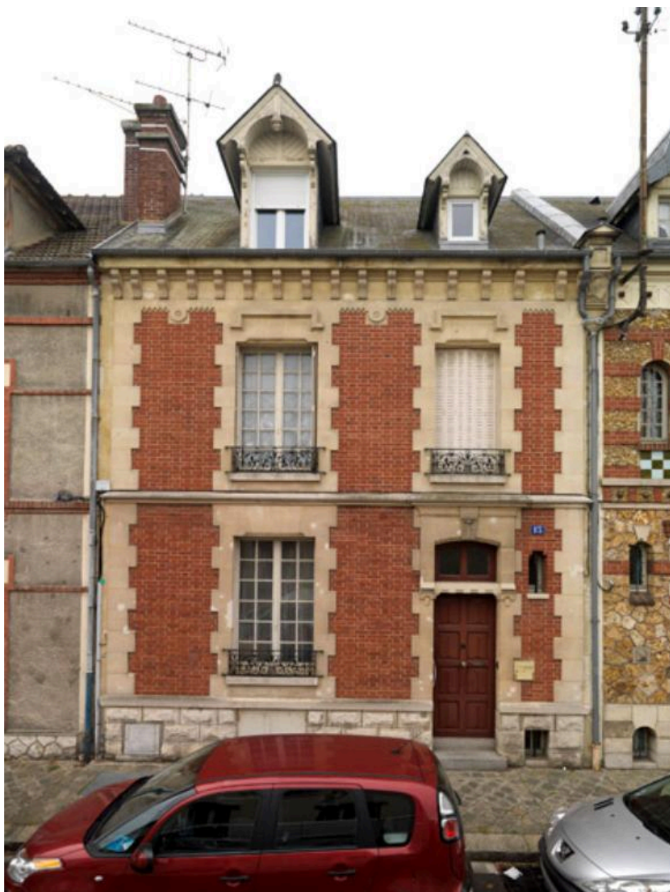
Façade du 15 rue Alphonse Durand.
