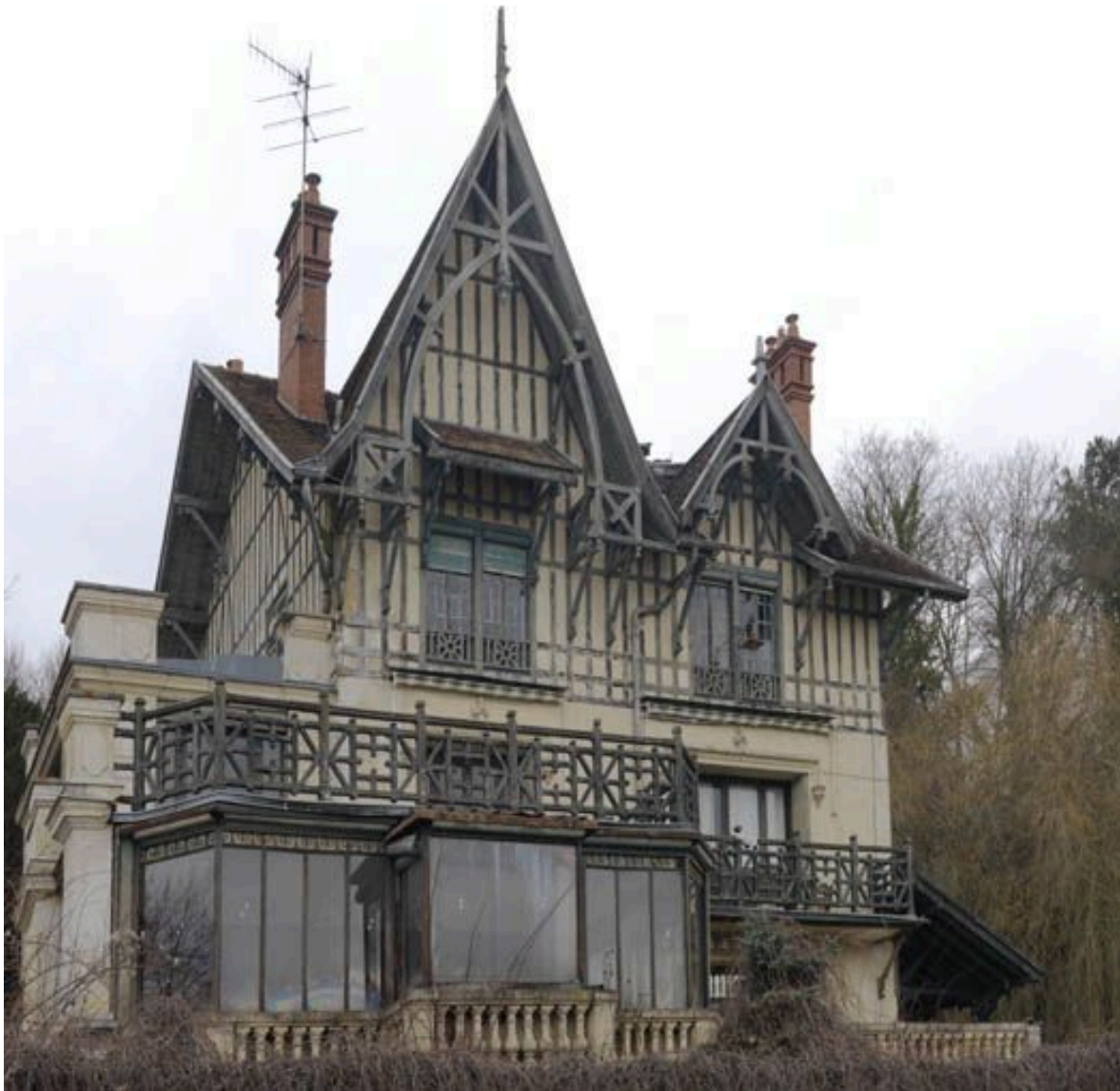
Villa des Fontaines-Dieu, travaux de serrurerie et construction métallique exécutés par l'entreprise Oudiou de 1896 à 1910.
