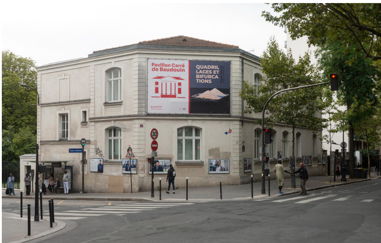
Façade postérieure des communs, angle des rues de Ménilmontant et des Pyrénées.
