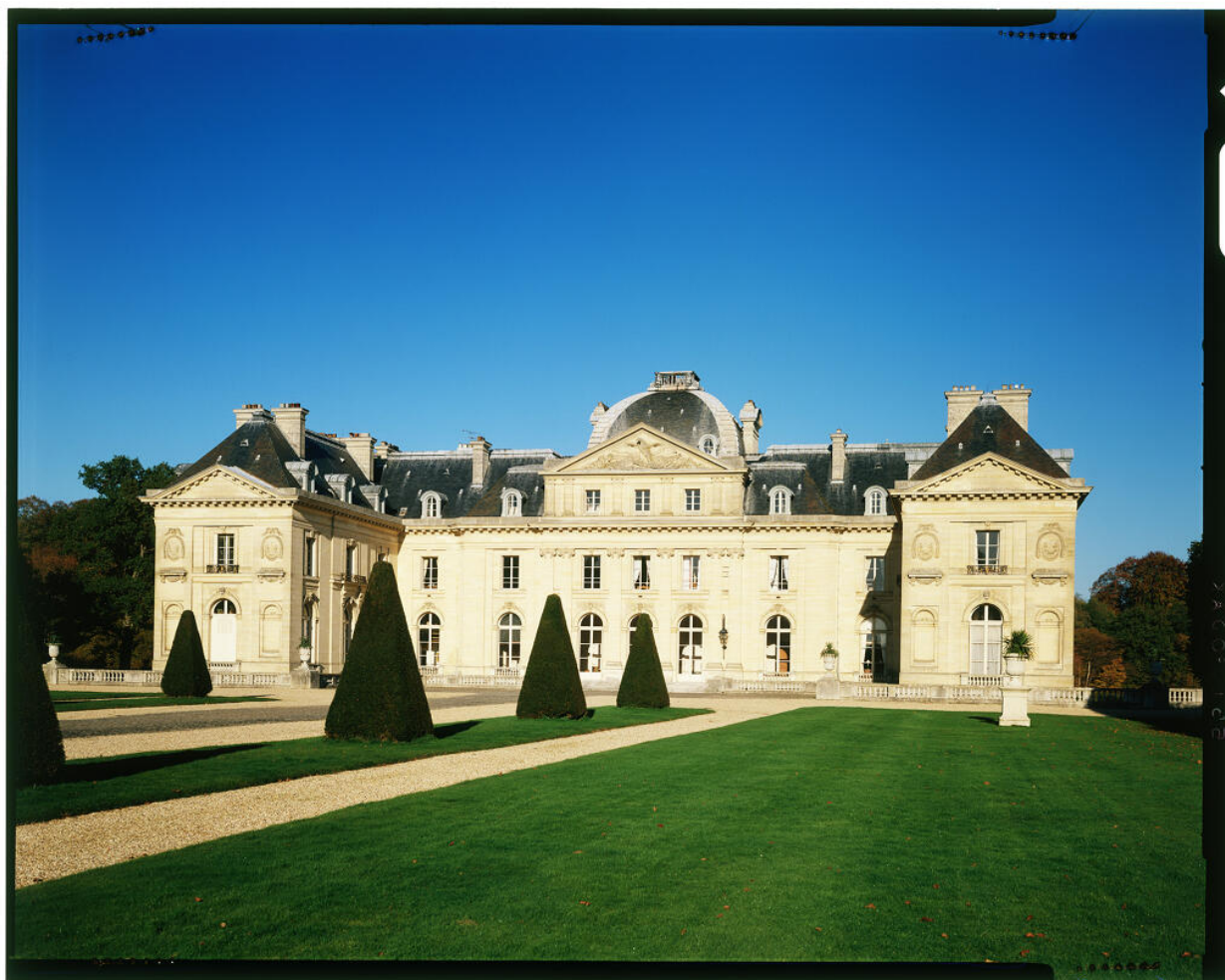
Façade ouest sur la cour.
