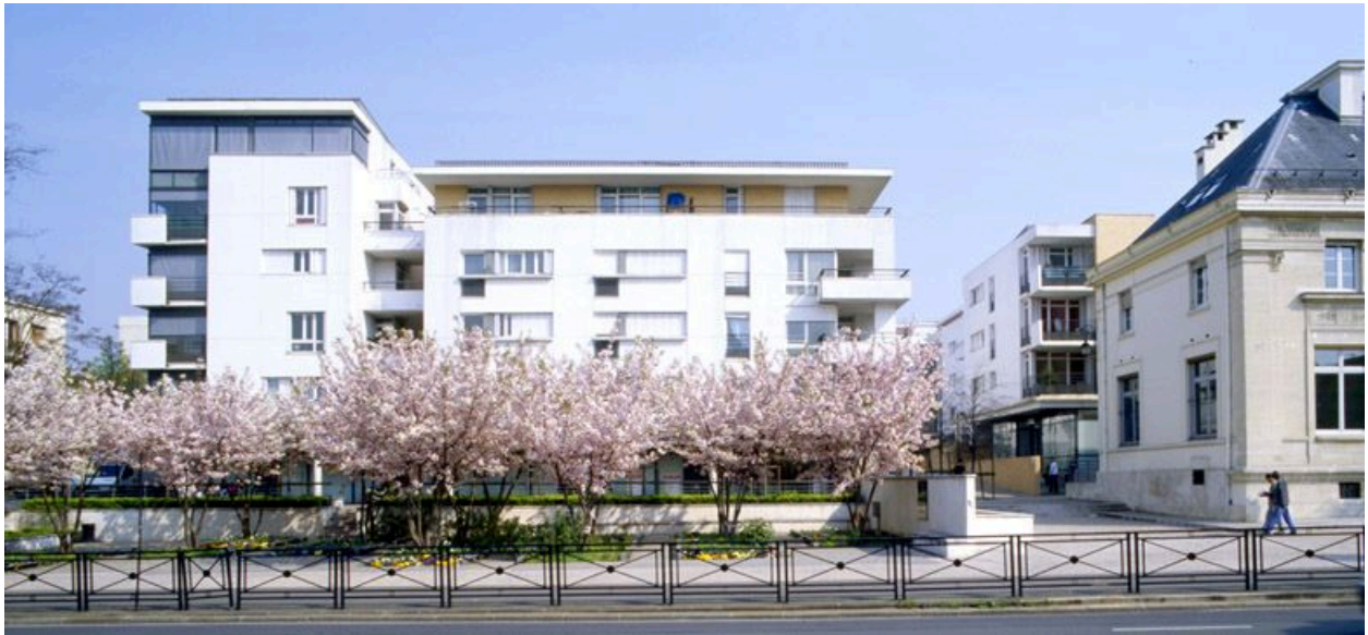
Ilot de la mairie, rue Louis Talamoni, Albert Thomas et Dupertuis. Vue d'ensemble de l'ensemble de logements sociaux construits en 1996 par Ignace Grifo.
